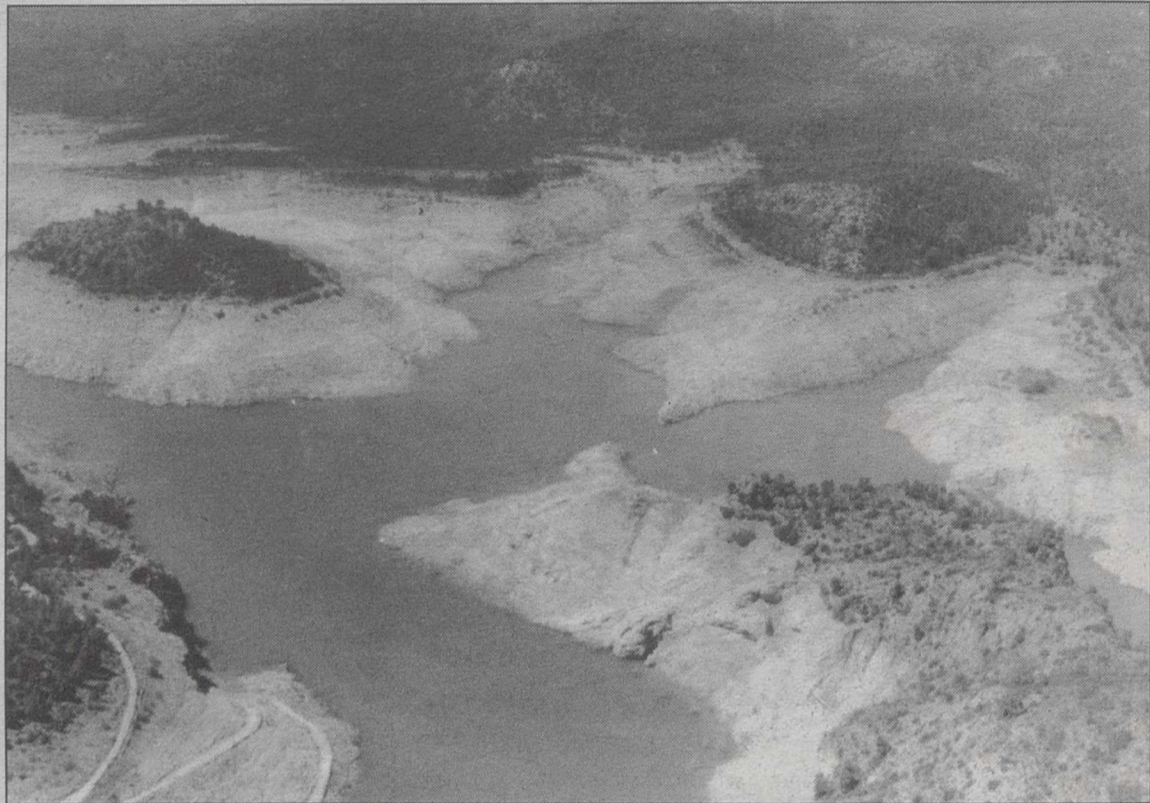
Page asegura que las obras de la autovía no pueden iniciarse debido al expediente de protección iniciado.
