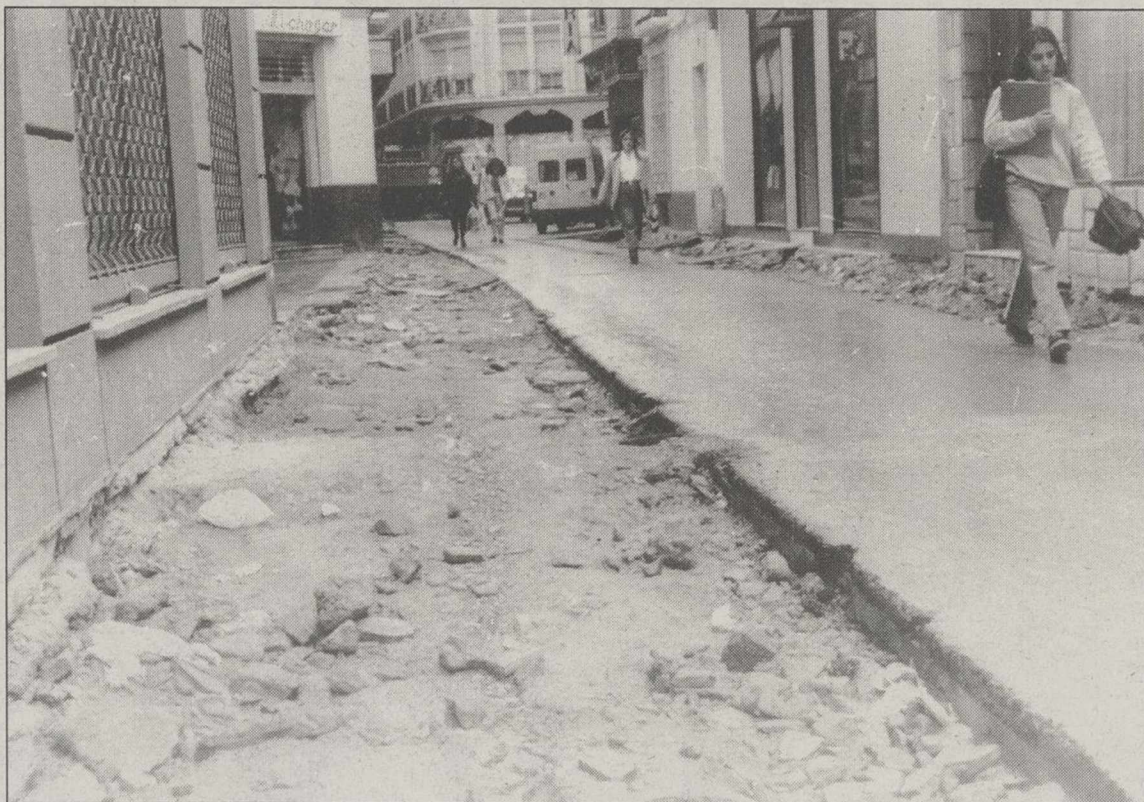
“Las obras en las calles Concepción y Mayor no pueden quedarse sólo en un cambio de ladrillos”.
