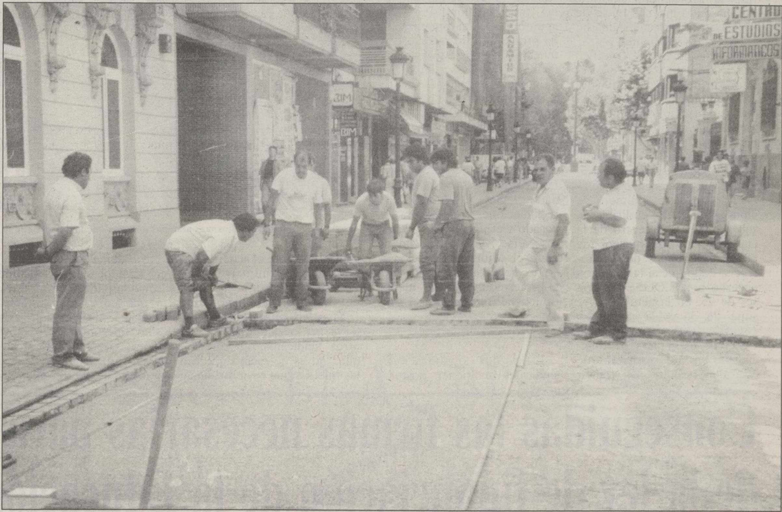
Parece que la eliminación de barreras arquitectónicas será una obra prioritaria.
