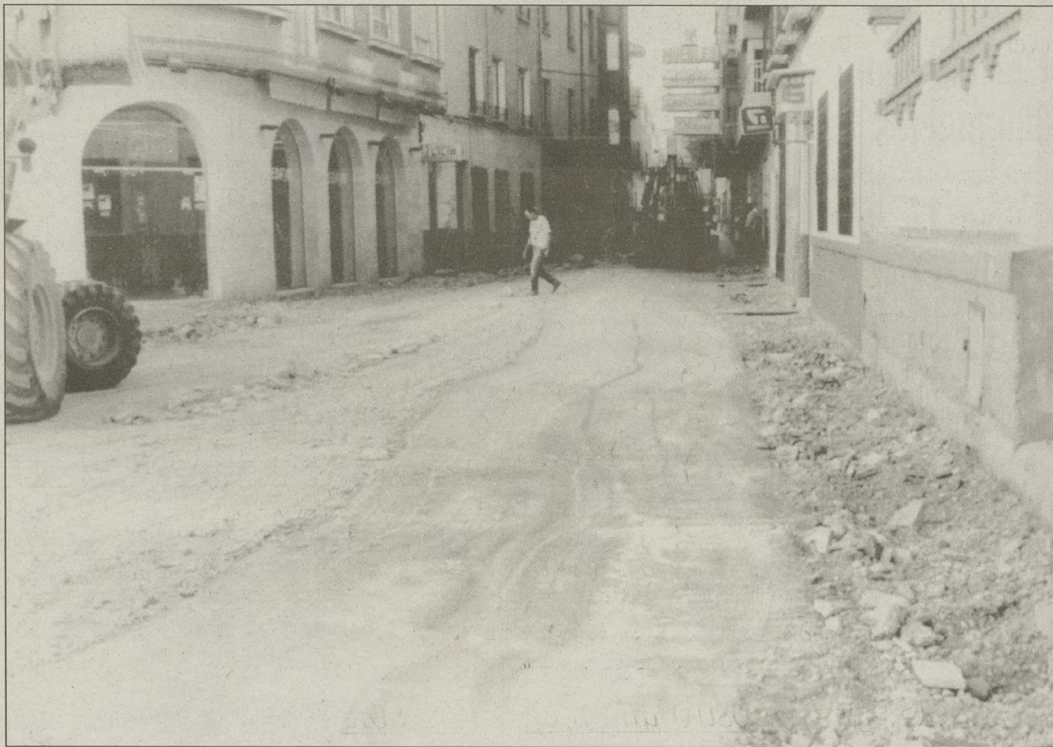
Durante los próximos meses, varias calles se pondrán 'patas arriba'.
