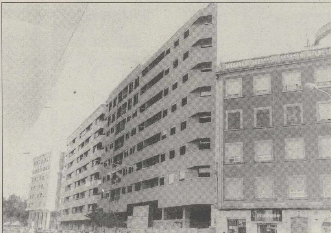
Las obras de Isabel la Católica correspondientes a la empresa Tecnur, totalmente paralizadas.
