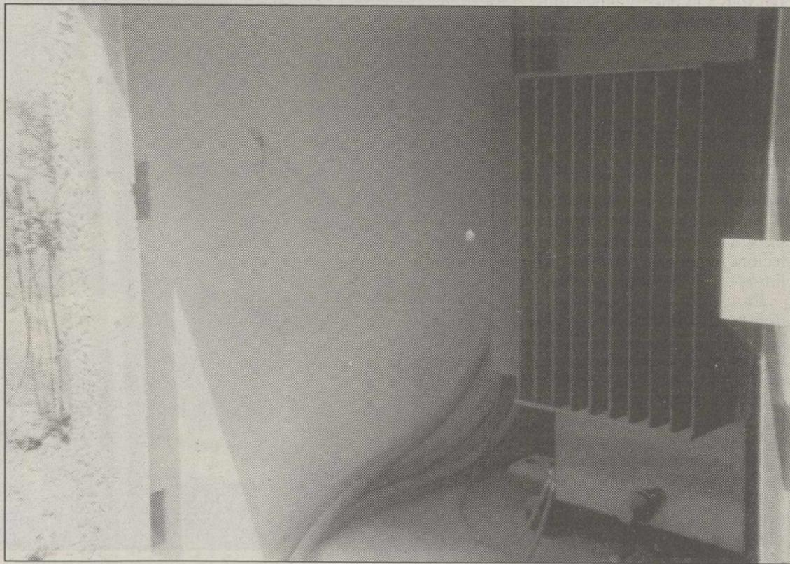
"La piscina del Paseo de la Cuba estaba funcionando con un transformador de alta tensión sin puerta".
