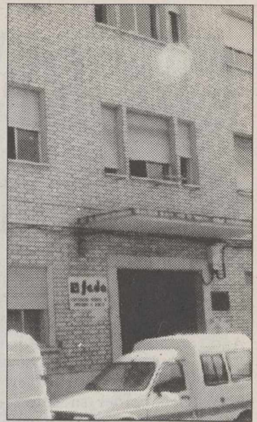
En estos locales se ubicará la UGT.
