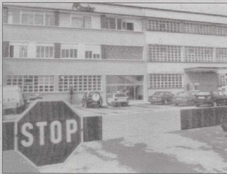
La vigilancia intensiva de la casa cuartel evitó la catástrofe.
