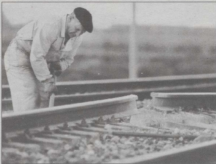
La circulación de trenes entre Pamplona y Zaragoza ha quedado restablecida.
