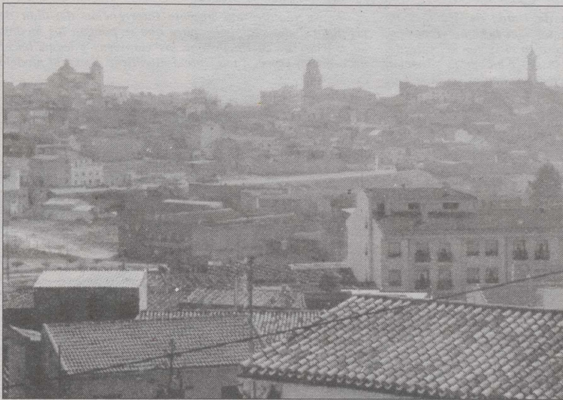
Se denuncia la problemática que padece el Barrio de San Vicente en infraestructuras.
