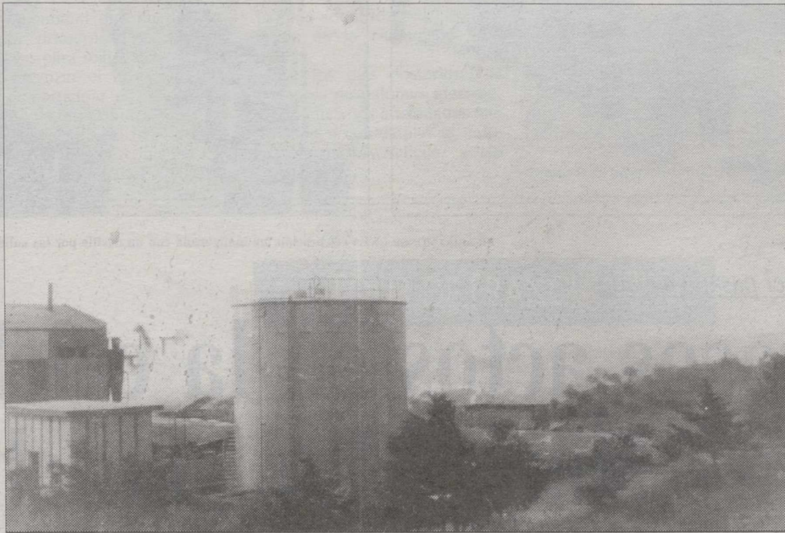
Las cisternas de Repsol Butano se encuentran al lado de la fábrica de madera.
