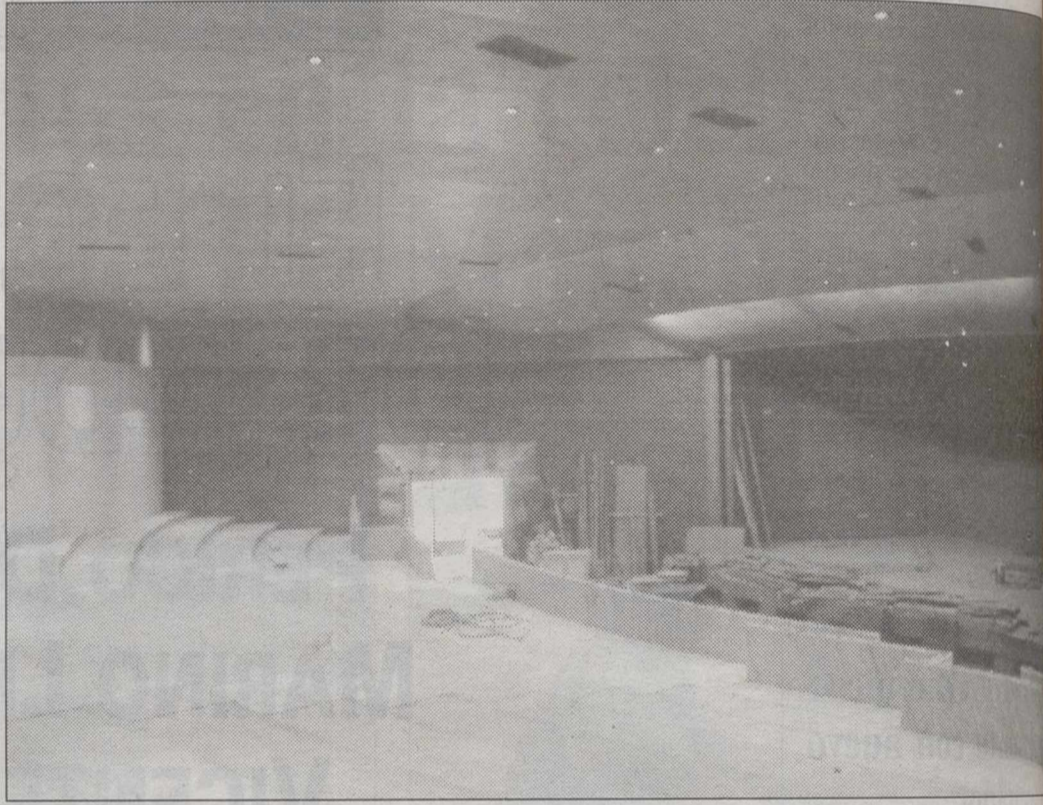
La Casa de la Cultura de La Roda está casi finalizada.
