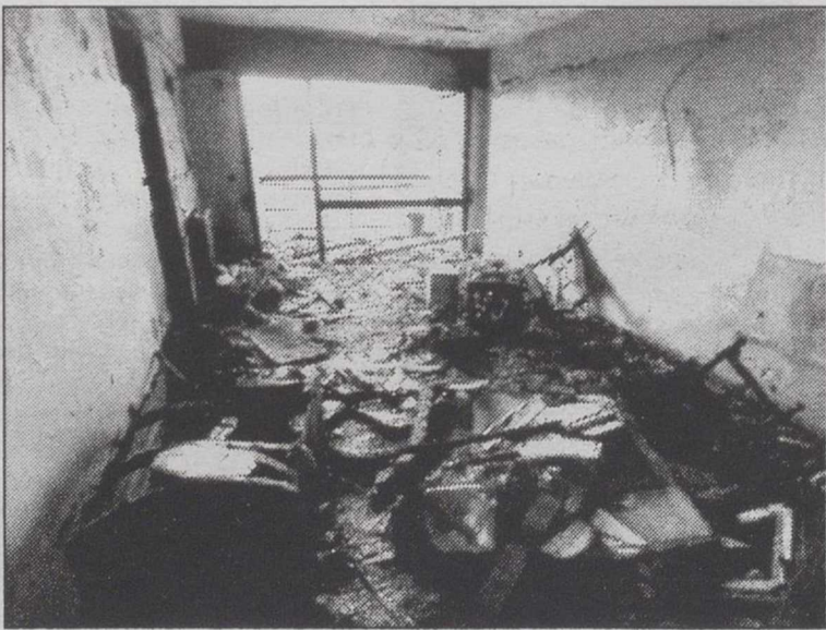
Aspecto del interior de la vivienda incendiada en Sopelana.
