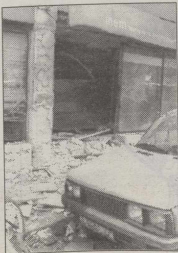
Imagen de los destrozos.
