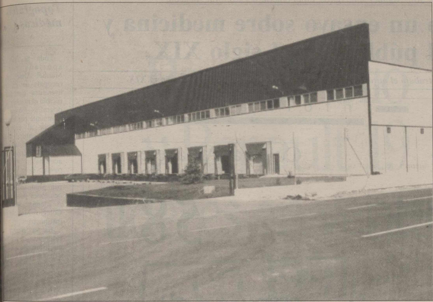
Polígono industrial de "Camporrosso", en Chinchilla, dedicado a la distribución comercial.
