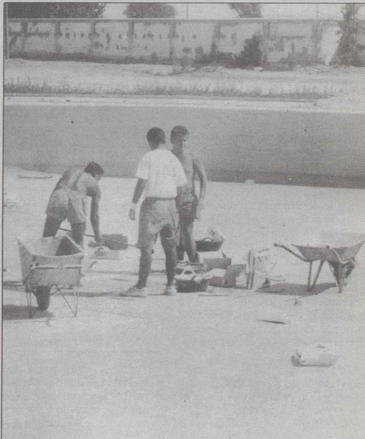
Las obras deberían haber finalizado en agosto del año pasado.
