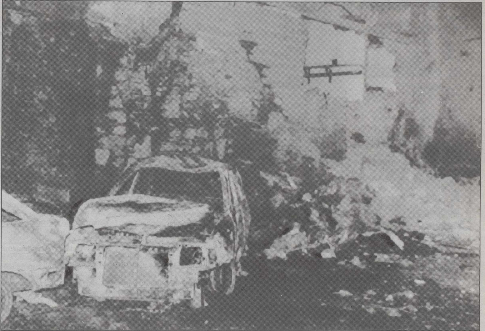
Aspecto que ofrecía la fachada de la casa cuartel de Irún tras la explosión de un coche-bomba.
