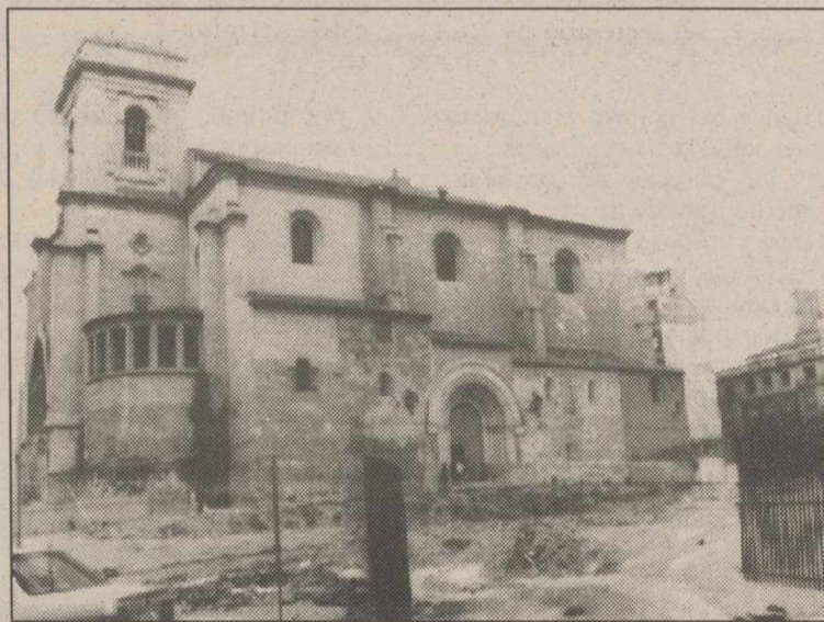
Las obras del aparcamiento llevan un ritmo muy lento.
