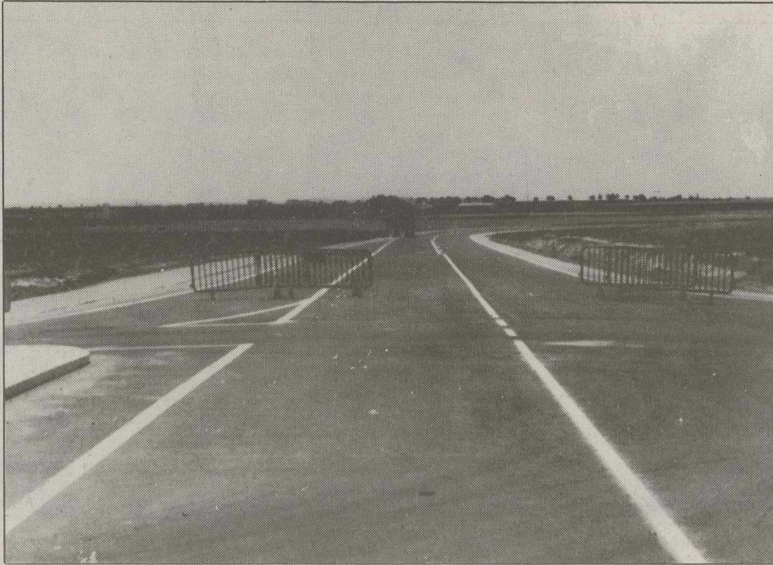
Según el PP, esta ley no contiene un elemento financiador de las obras que se pueden hacer en las carreteras.
