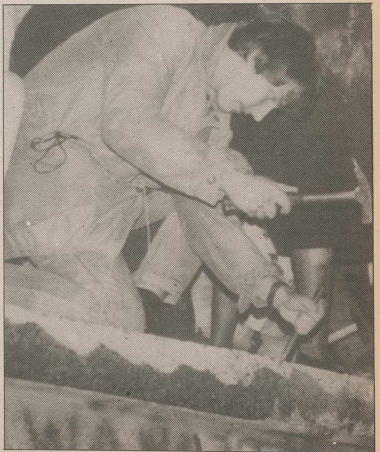
La demolición del muro fue rapidísima.
