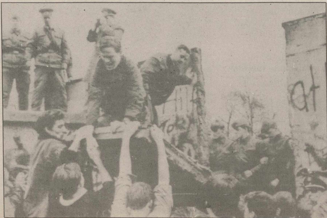
Un grupo de berlineses quitan un trozo de muro en presencia de guardias de la RDA.
