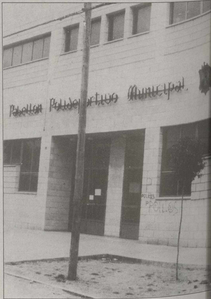
Pabellón Polideportivo Municipal.
