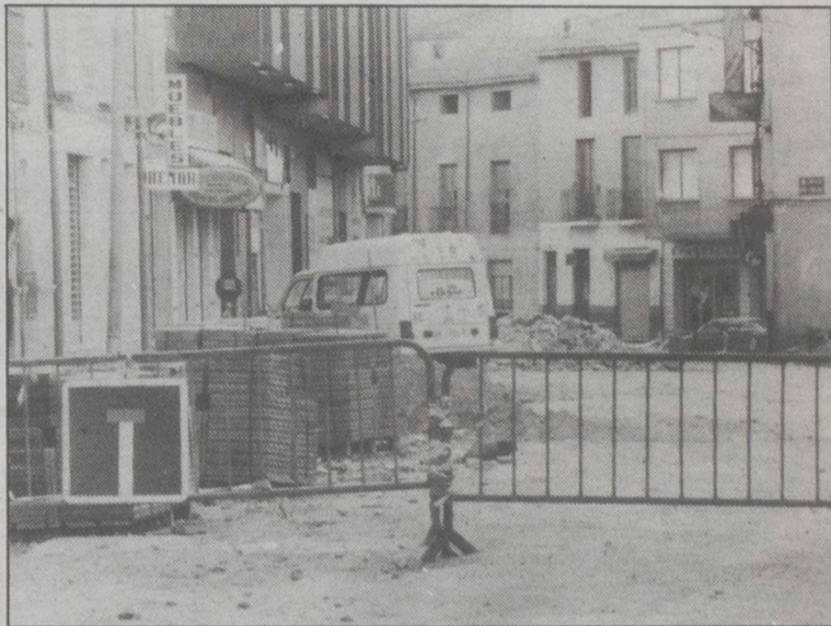
Obras en la calle Corredera.
