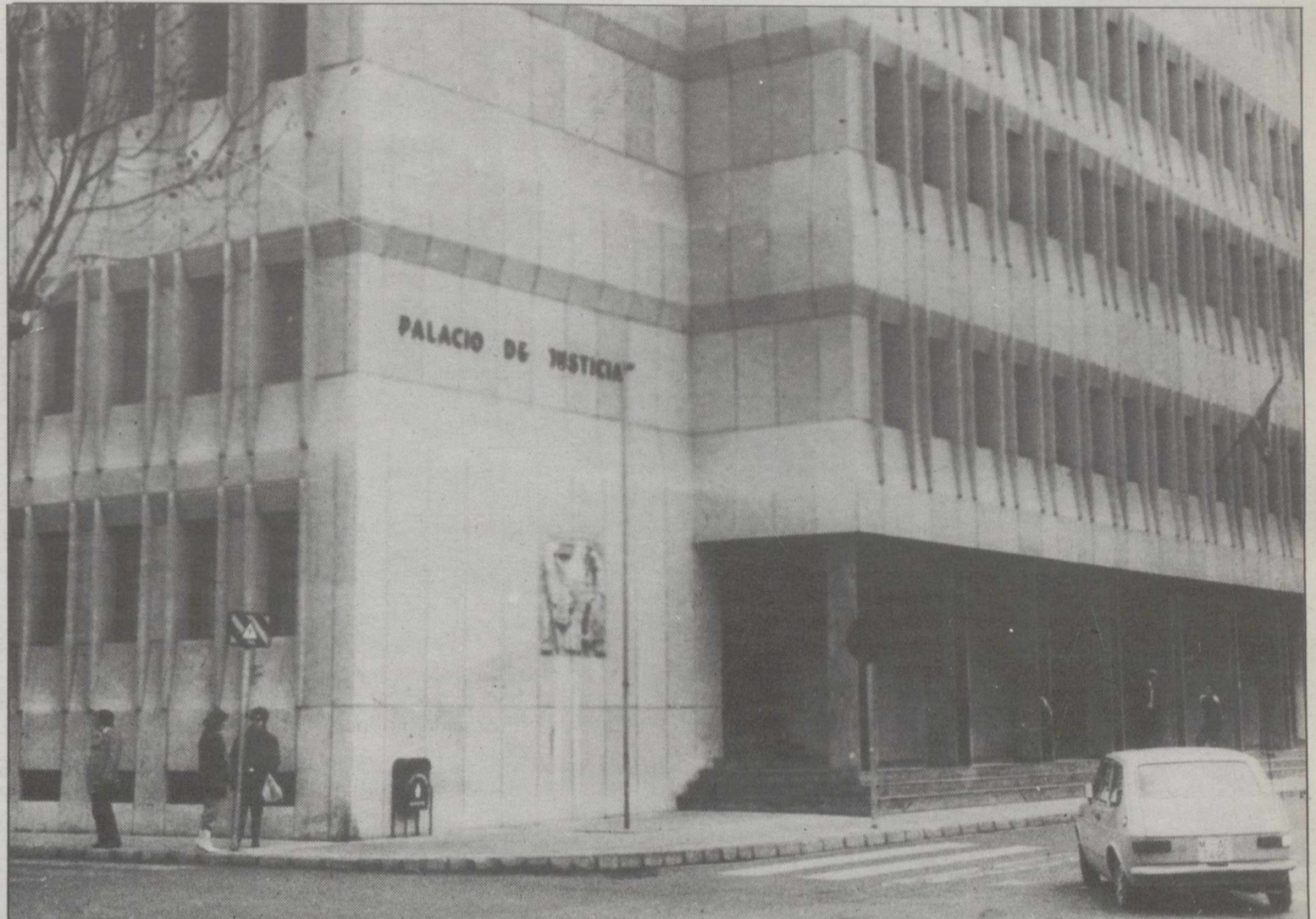
El Palacio de Justicia, que alberga al TSJ regional y a la Audiencia Provincial, absorbe el 60% de los gastos de reparación y equipamiento.
