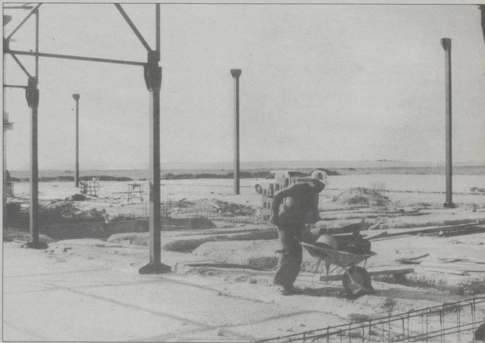
El helipuerto se construye en una finca de 100.000 m 2 , en la carretera de Motilleja, con una inversión cercana a los 500 millones de pesetas. LUIS MIGUEL
