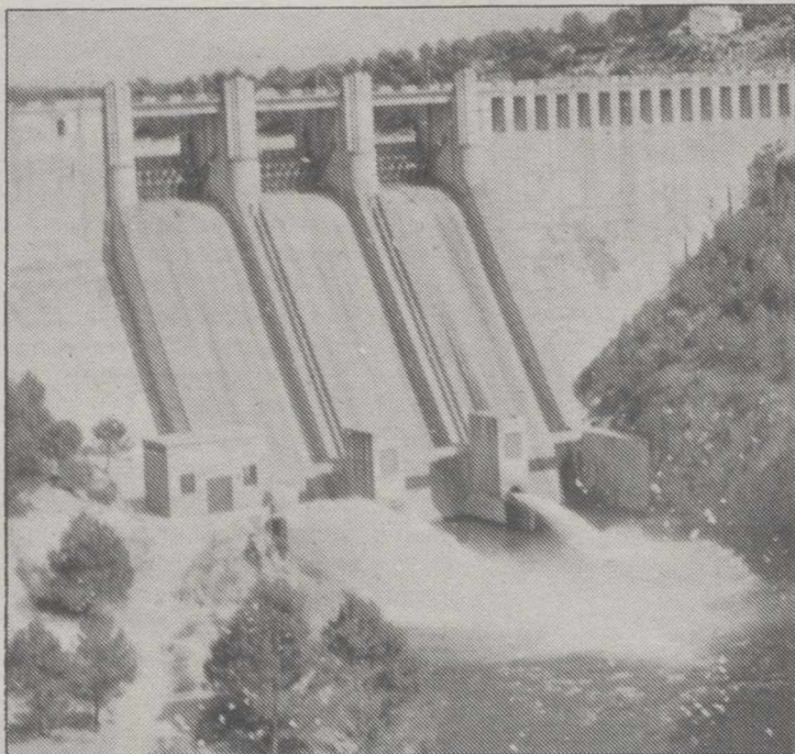
Fuster cree necesario un mayor aprovechamiento hidráulico.
