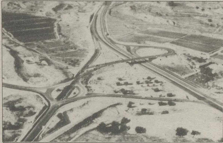
Vista aérea de la autovía Almansa-Albacete.
