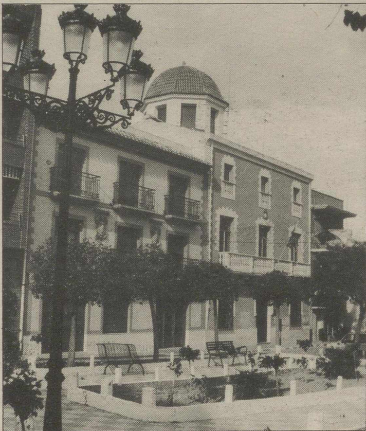
En Tobarra se reparará el sistema de alumbrado público.
