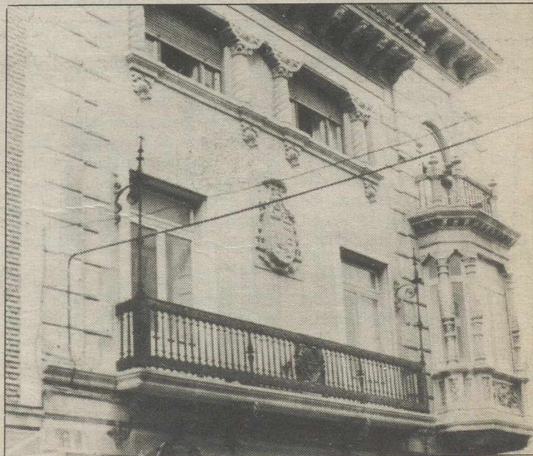
Se ha respetado totalmente la bella fachada.
