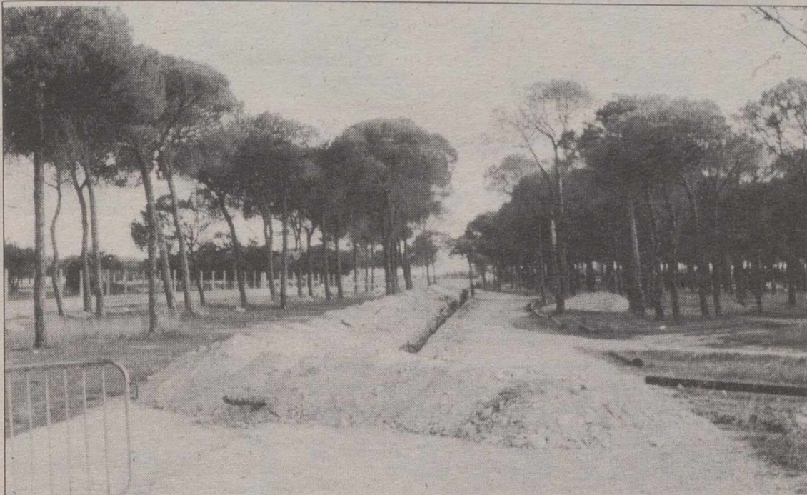
Tras la autorización del juez, el Ayuntamiento podrá continuar con las obras de acondicionamiento de "La Pulgosa".
