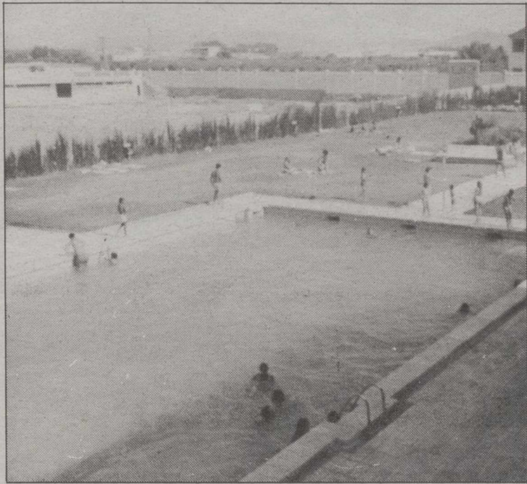
Piscina Municipal de Hellín, ubicada junto al recinto ferial.
