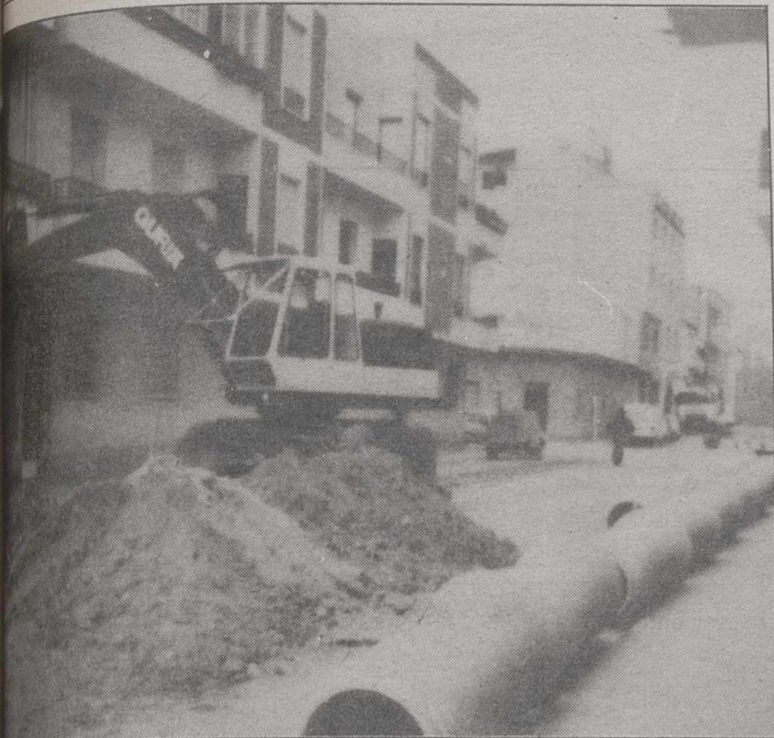
Comenzaron las obras de alcantarillado en el centro de la ciudad.
