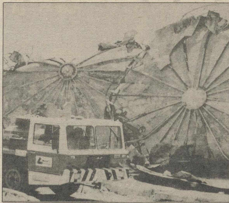
Una grúa tuvo que ayudar en las tareas de desescombro.
