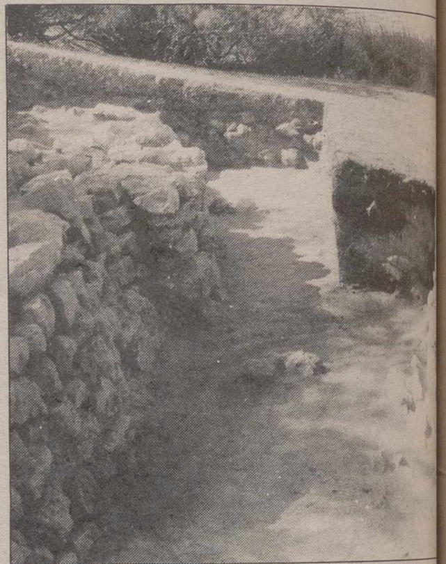
La insuficiencia económica, causa de la interrupción.
