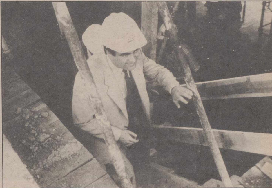
José Bono inspeccionando las obras del nuevo Ayuntamiento.
