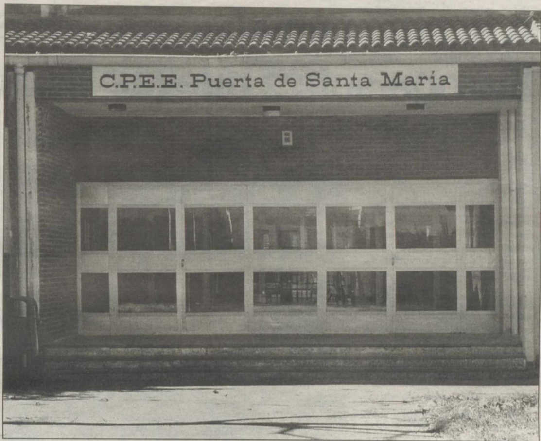
Como puede apreciarse, la entrada al centro no tiene rampa
