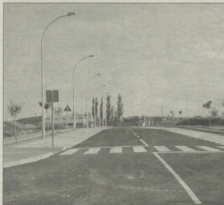
Uno de los viales del parque industrial avanzado
