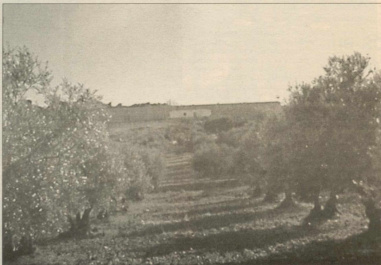
Depósito de agua potable de El Tomillar.
