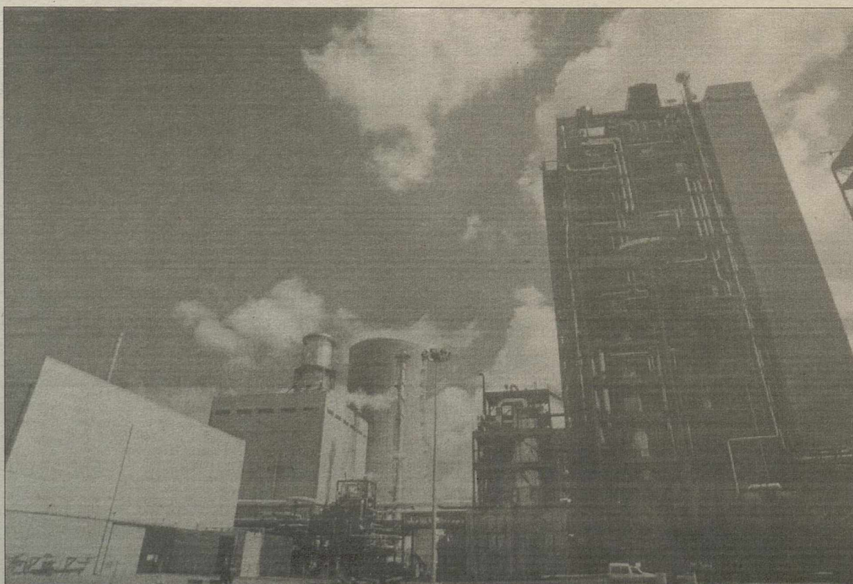
La planta de desulfuración ya ha producido azufre.
