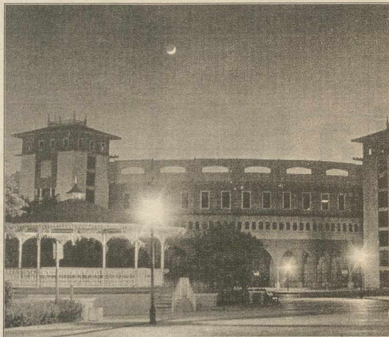
La Monumental de Aguascalientes, en México.
