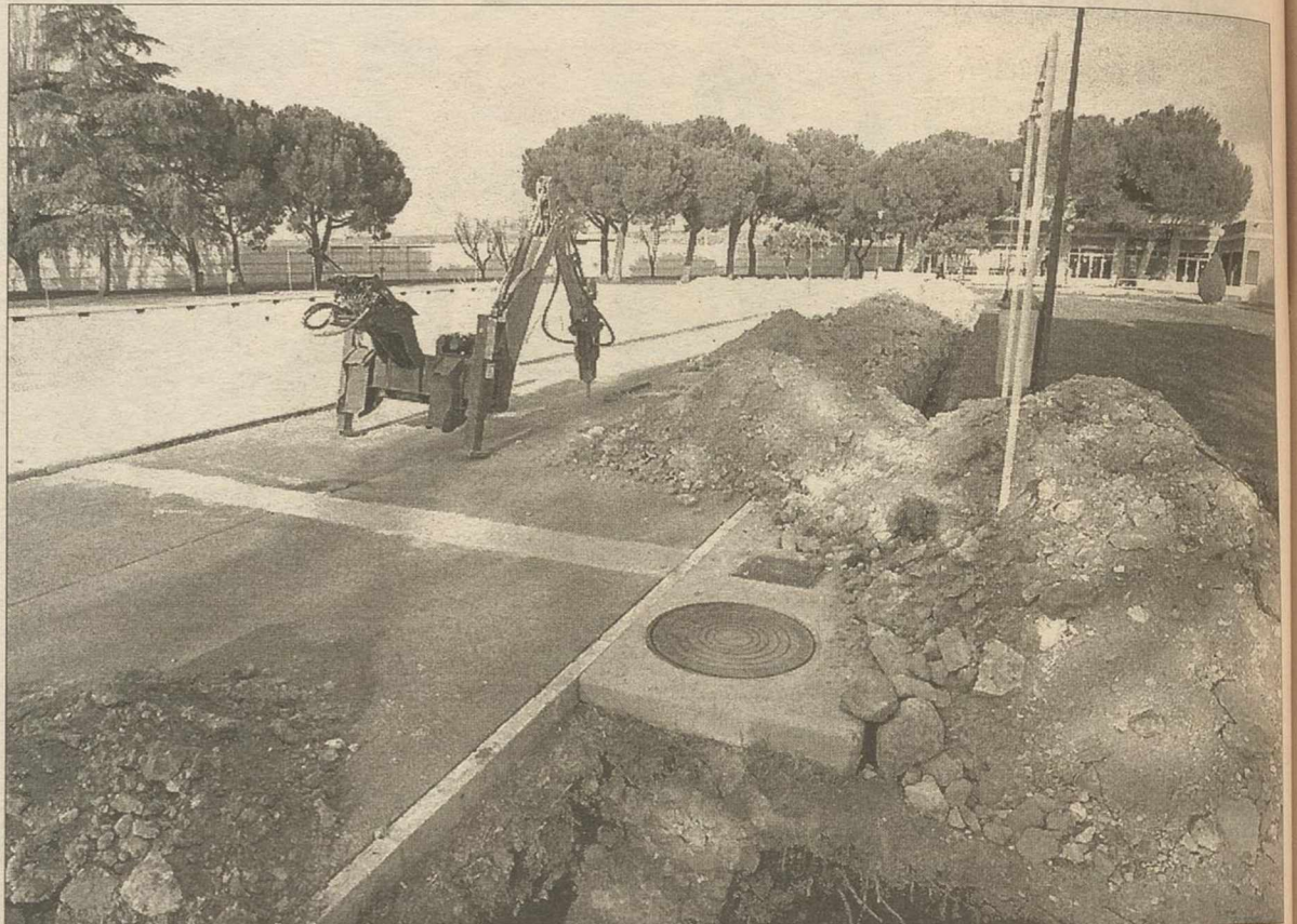
Primera obras de la piscina del polideportivo.
