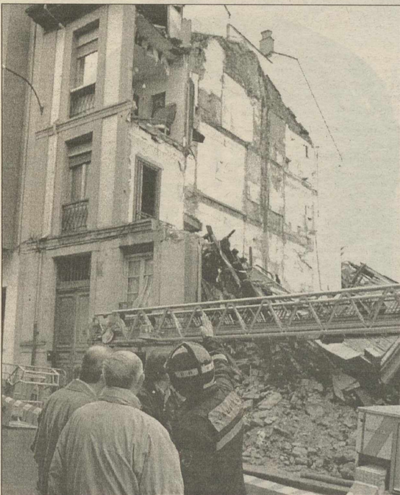
Estado en el que quedó el edificio que se derrumbó.
