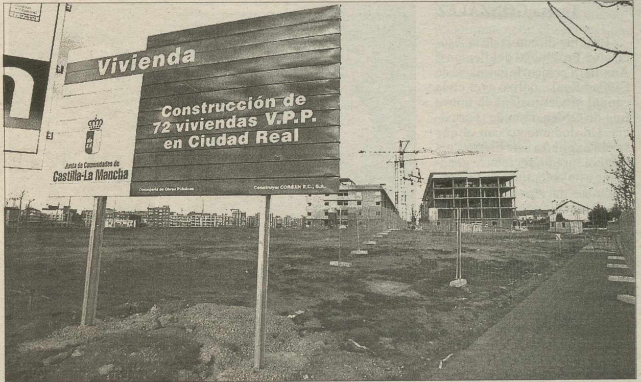
La Junta ya ha iniciado las obras de las 72 viviendas para jóvenes en los terrenos de RENFE.
