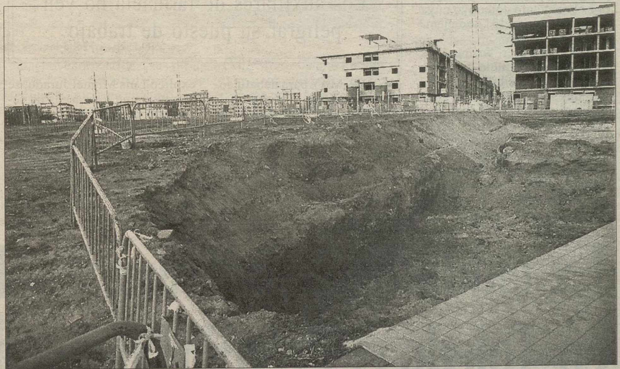
Las obras estarán concluidas en mayo del 2000, según las previsiones.
