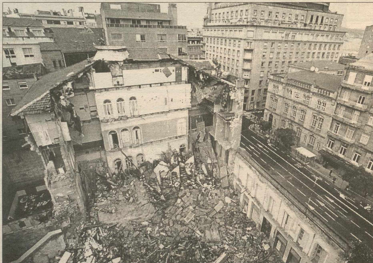
Estado en el que quedó el edificio.
