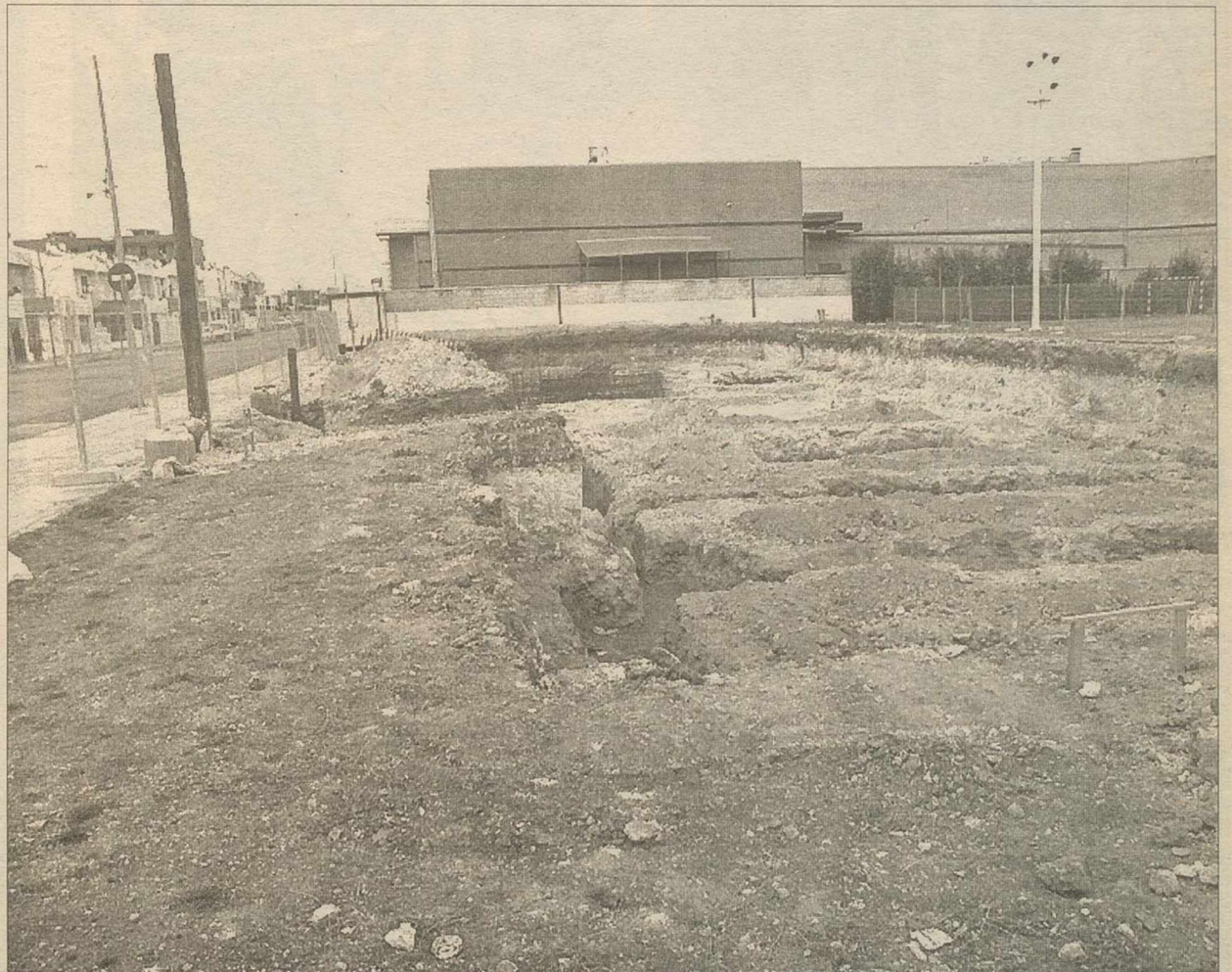
Las obras están en su fase preliminar.
