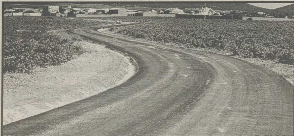
Camino estabilizado con alpechín.
