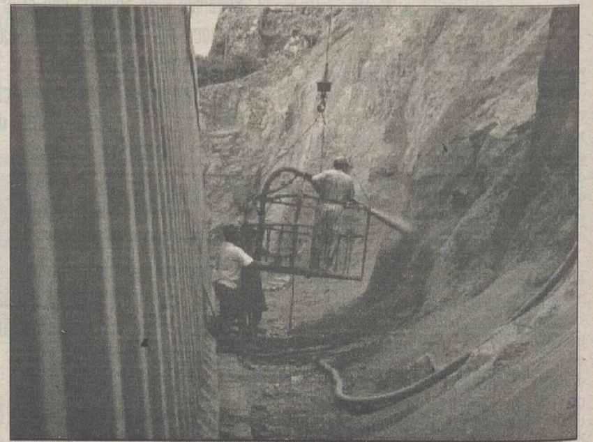
Los taludes de La Rincona se reforzaron recientemente.
