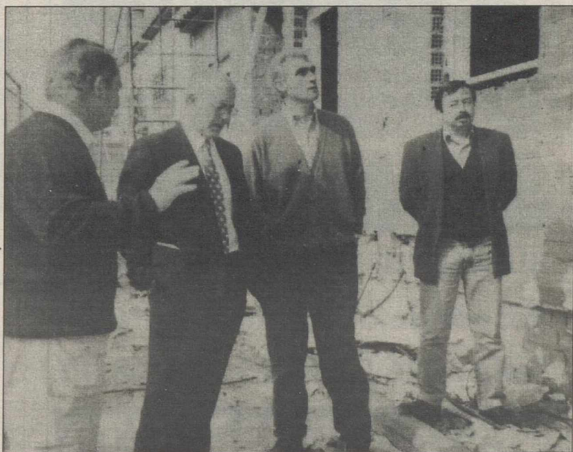
Fernández-Pacheco visitó las obras, que van a buen ritmo.
