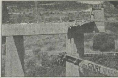
Los obreros montaban las maderas para sujetar el hormigón del puente cuando se produjo el desplome del puente
