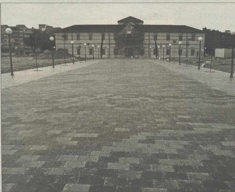
Paseo de acceso al nuevo Rectorado desde la ronda.
