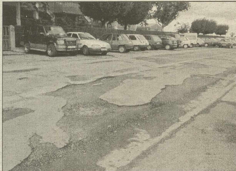
Así estaba la calle Caracola antes de las obras.
