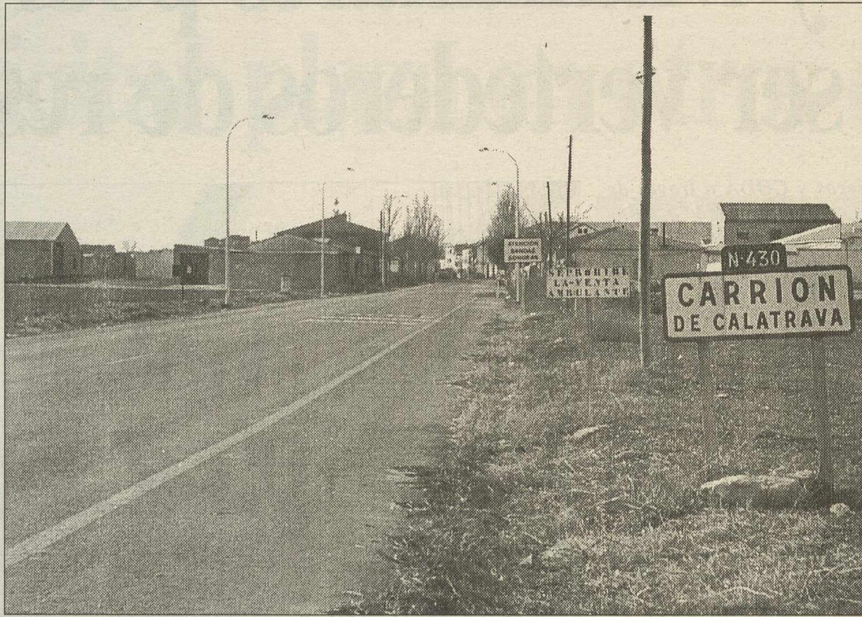
Con la obra se hace más claramente perceptible la intersección.
