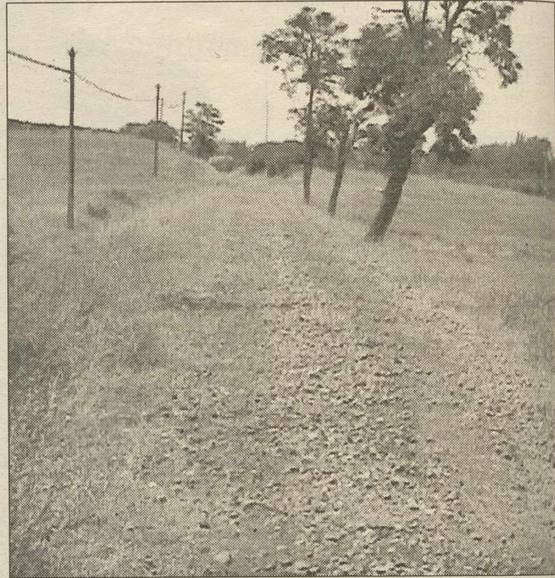
El antiguo tendido de vía estrecha está en buenas condiciones. P.A.
