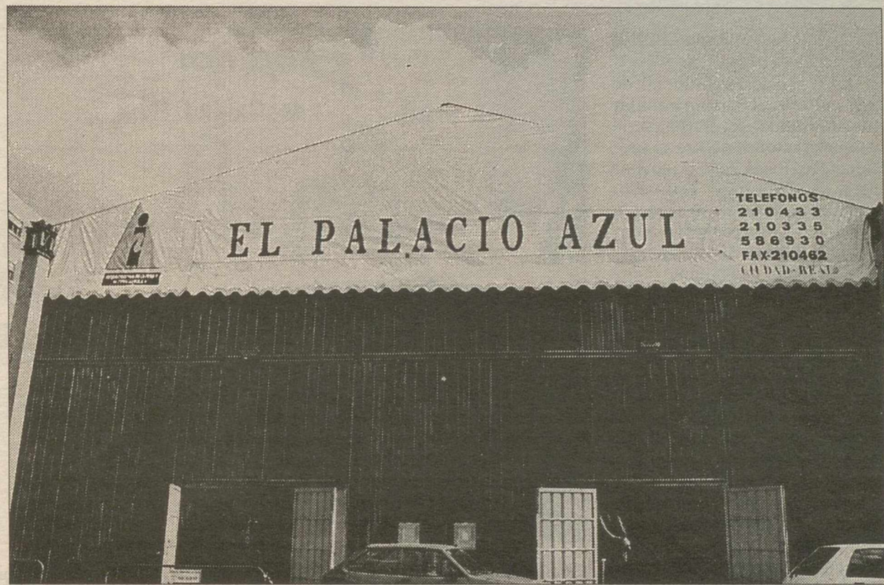
El montaje de la carpa está prácticamente concluido, centrándose ayer los trabajos en la colocación de la tarima. RUEDA
