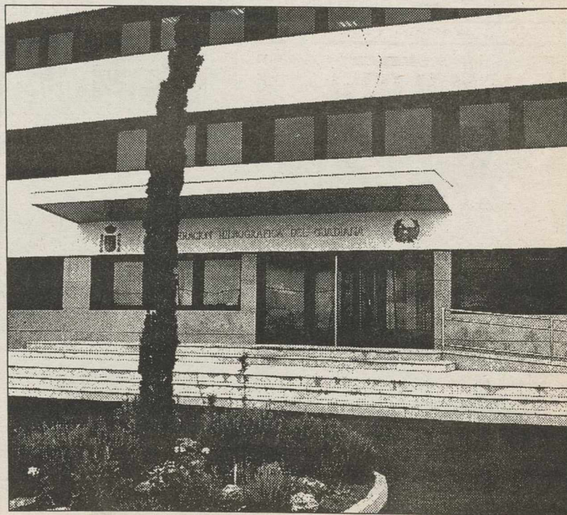
Sede de la Confederación Hidrográfica del Guadiana en Ciudad Real.
