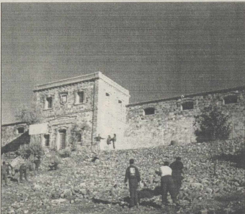
Los trabajos de la Escuela Taller se han prolongado durante un año.
